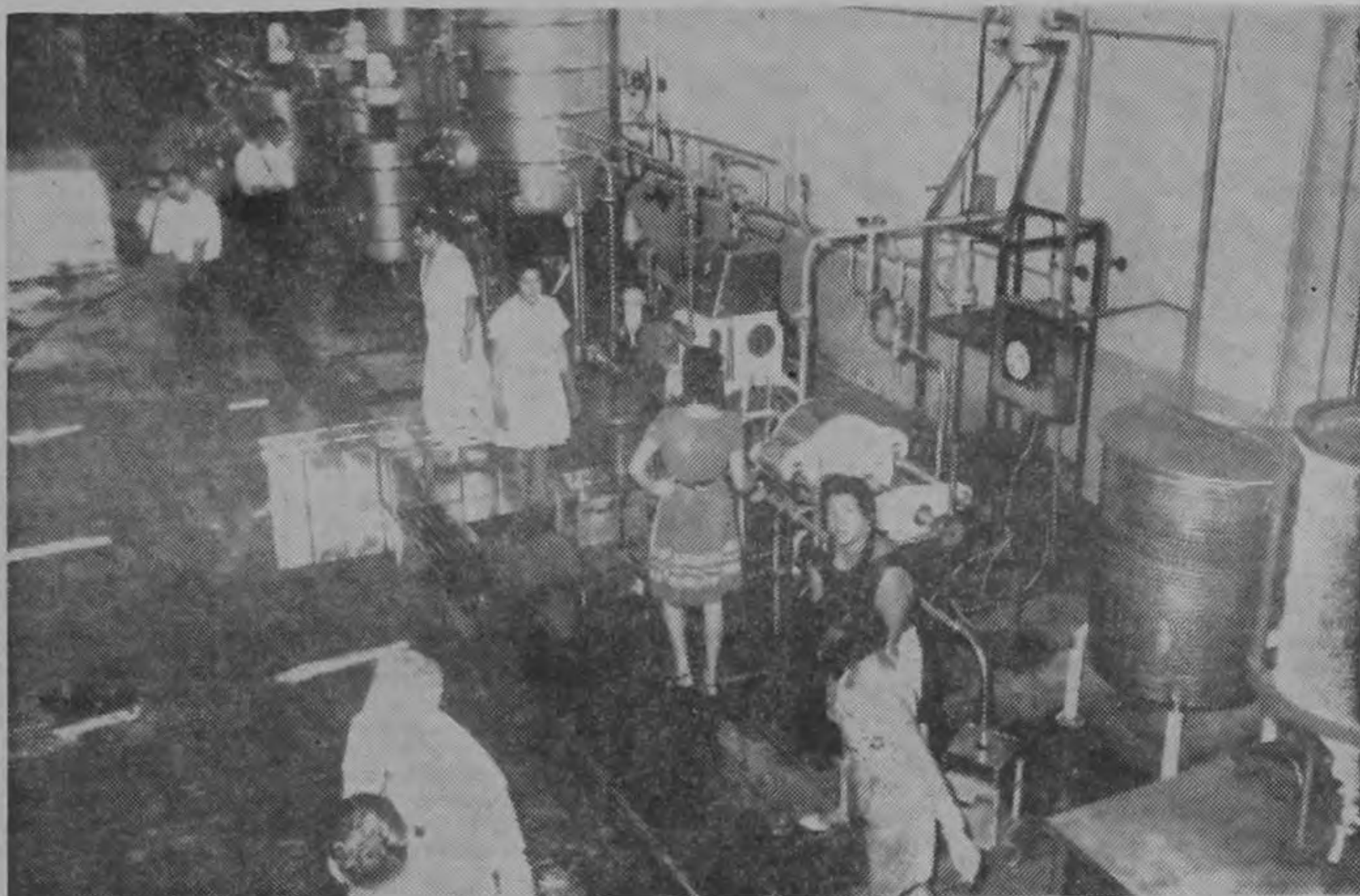
Tanques correctores, "Thermobrake", Rapid-sonic, (desintegrador del sistema celular de las frutas). Además el marcador automático de temperaturas. Parte importante del equipo Bertuzzi.
